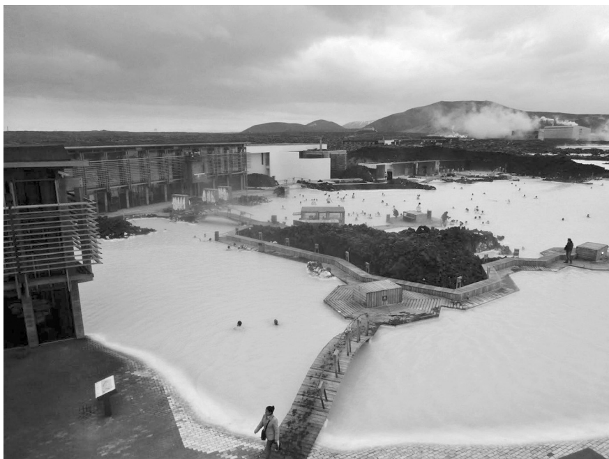
Рис. 9. Исландская геотермальная электростанция. Используемая для выработки электроэнергии термальна́я вода обладает целебными свойствами. Рядом с геотермальной станцией (вдали на заднем плане) образован курорт «Голубая лагуна» с искусственными бассейнами
