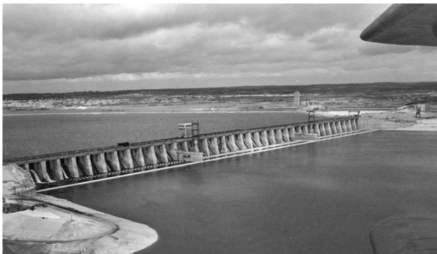
Рис. 7. Плотина Куйбышевской ГЭС
